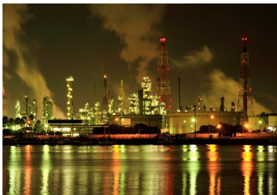
JXTG エネルギー（株）堺製油所
